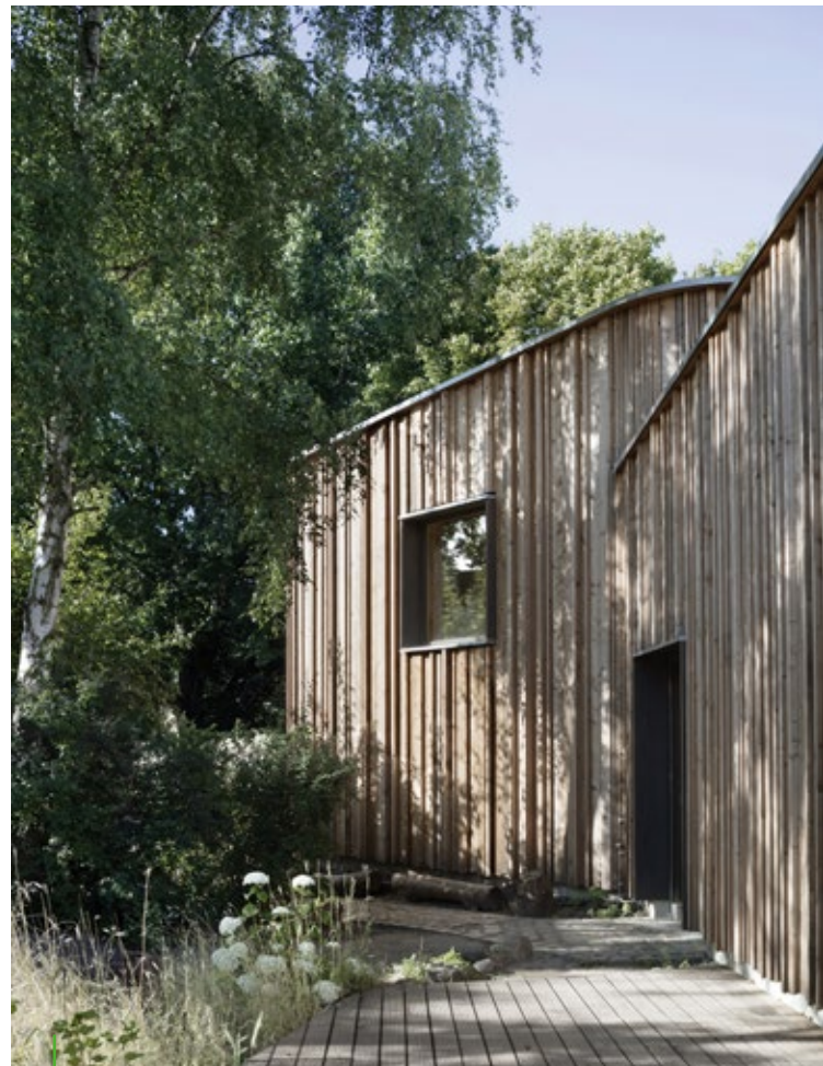
Fassadendetail – plastisches Fassadenrelief
