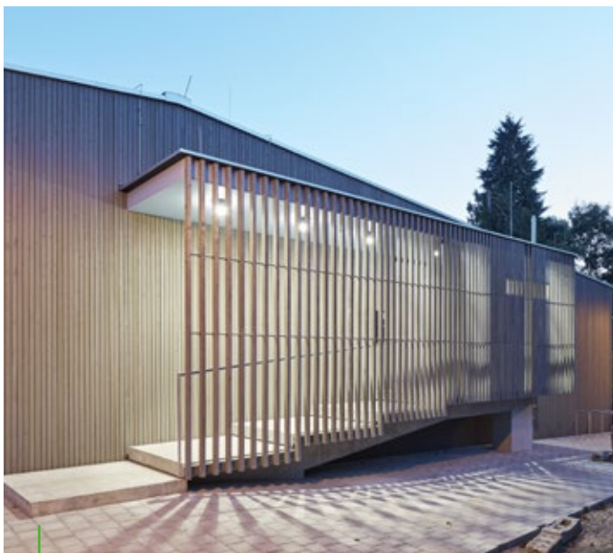
Hauptzugang Gemeindesaal/Pfarramt EG
